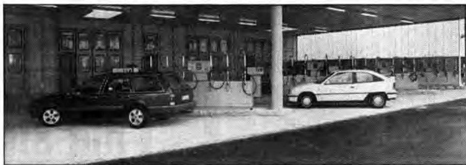
Start: Nach nur neun Monaten Bauzeit ist die neue Super-Tankstelle betriebsbereit
