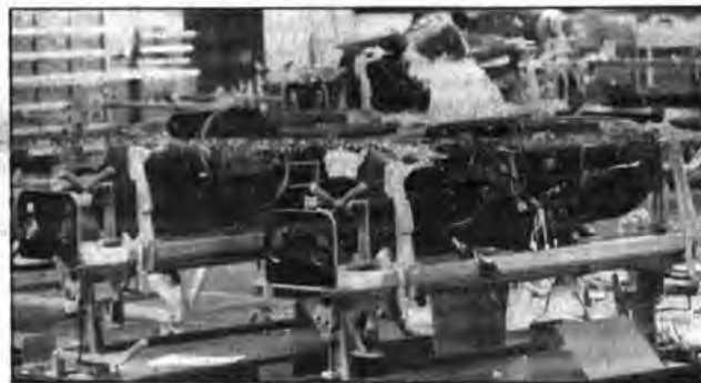
Vorbereitung: Alle Teile werden vor dem Einbau montiert
