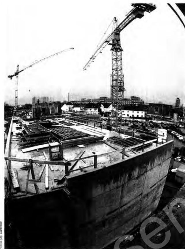
Groß geworden: Der Neubau hat die Höhe des Gesenkbaus erreicht
