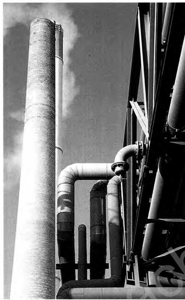
Volles Rohr: Seit 30 Jahren raucht im Kraftwerk der Kamin
