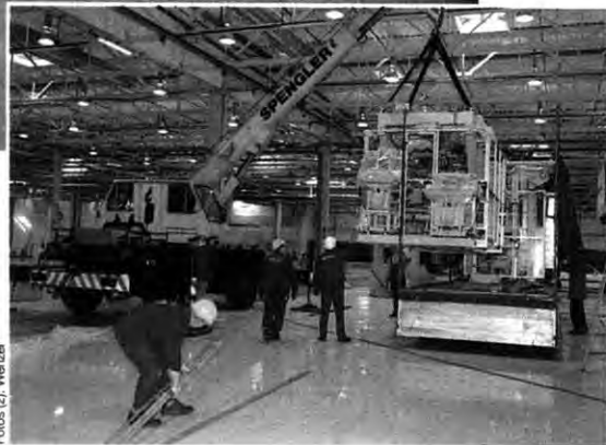
Premiere: Ein Kran hievt die ersten Anlagen für die neue Motorenproduktion in die frisch renovierte Halle
