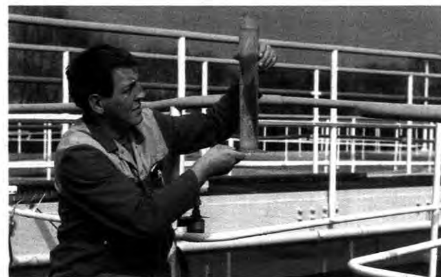
Wasser marsch: Die Überprüfung der Filteranlage gehört...
