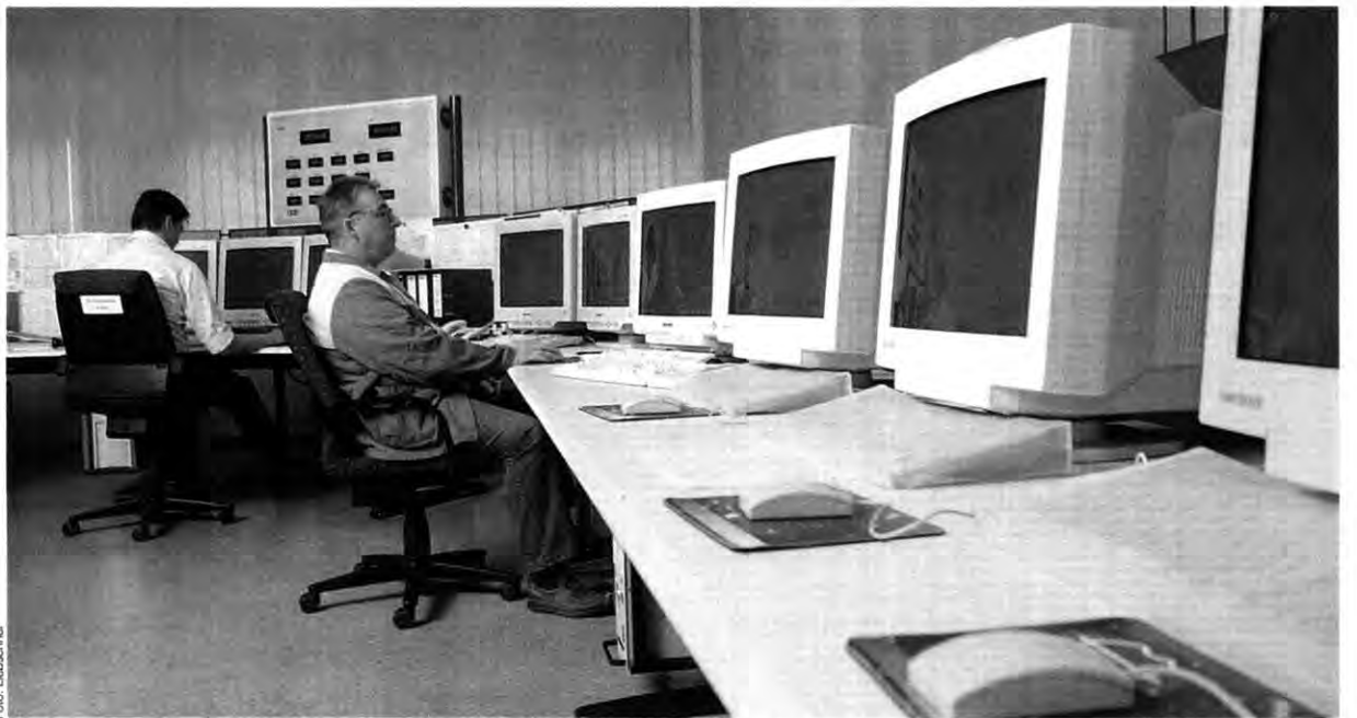
Auf einen Blick: Im „Energy Control Center“ haben die Kraftwerksexperten die Versorgungslage konstant unter Kontrolle
